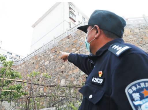
4月12日,民警查看高20多米的堰墙。
