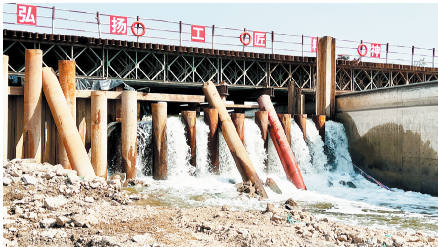
现场采用不断水作业。
