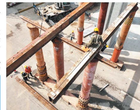
鲁山大道项目现场
