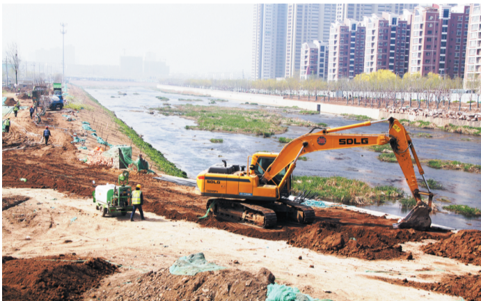
孝妇河生态观光带正在建设。
