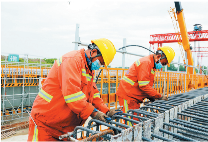
沾临高速黄河特大桥施工现场，工人正在捆扎钢筋。
