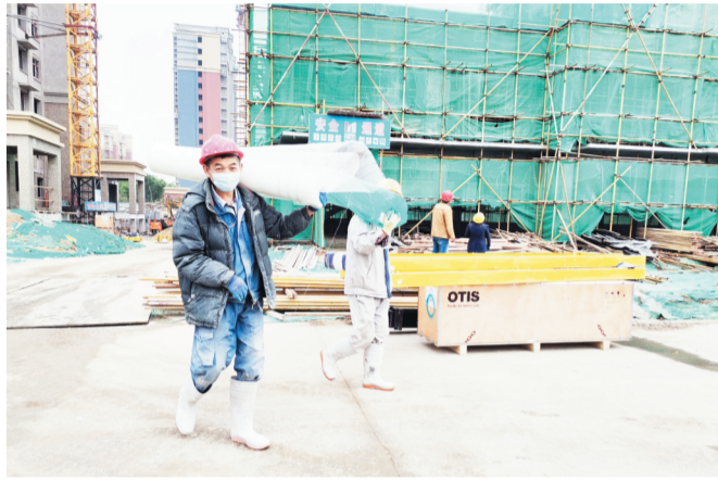
5月9日,在张店区房镇董家新村,工人正在紧张施工。
