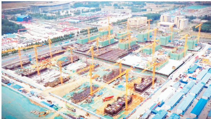
张冉新村施工现场
