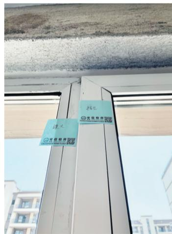
窗户玻璃压条拼接不平整、缝隙大。
