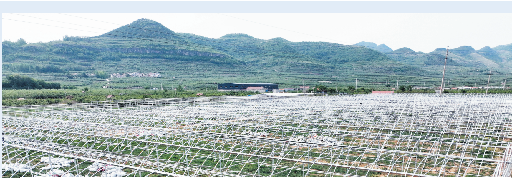
东里镇东安村东安城葡萄园示范基地在建大棚
