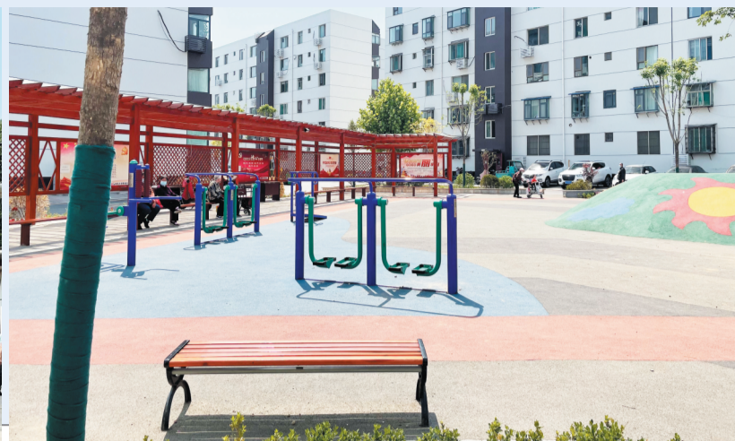
2021年完成改造后的世瑞苑小区
