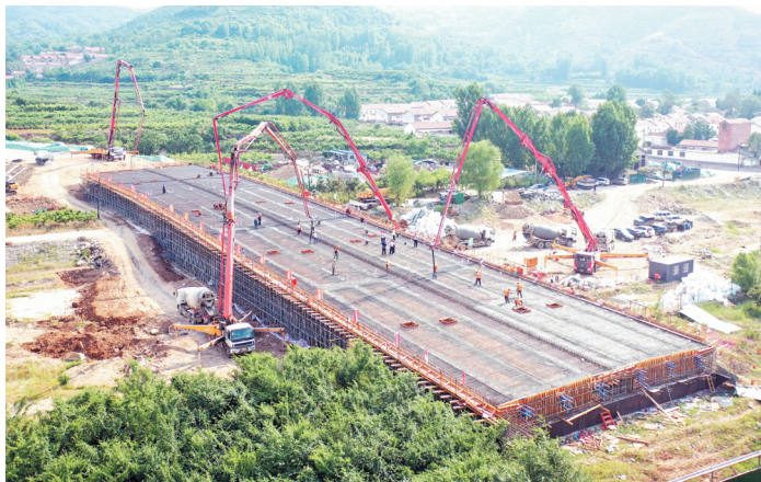
桥梁板浇筑现场
