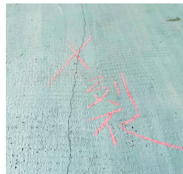
这面墙上长长的裂纹很明显。
