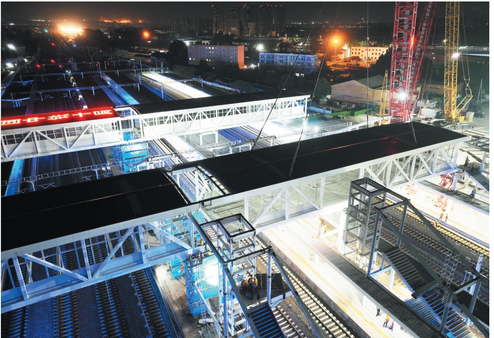
6月13日凌晨,随着最后一长49.3米、重224.22吨的天桥钢桁架徐徐落下,由中铁十局集团承建的淄博站客运设施改造工程旅客天桥和市政天桥跨站内吊装作业顺利完成。至此,淄博站改造的关键性节点全部打通,百年老站——淄博站即将实现南北新跨越。此次吊装作业采用国内罕见的特大型2000吨级履带吊,是目前国内仅有的跨越运营车站同时吊装的双天桥工程。
