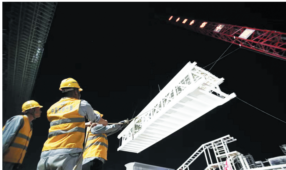
6月13日凌晨,吊装期间,地面上的工人用绳索保持吊装稳定性。
