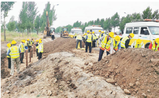
抢险人员进行路基修复演练。
