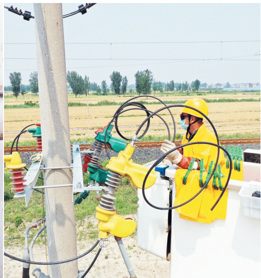
工作人员在起凤镇东巩村开展带电作业。
