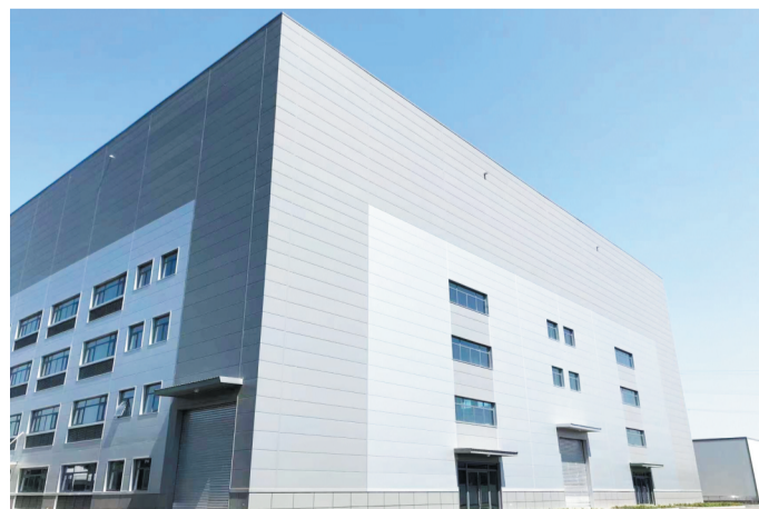
预填式中空玻璃不锈钢间隔条生产厂房
