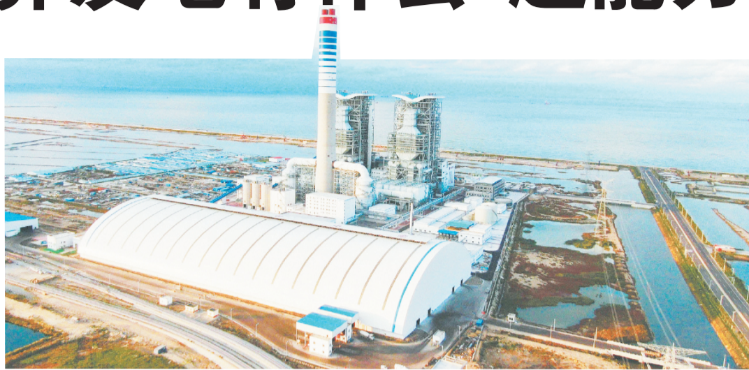
2020年11月11日,大唐东营发电有限公司的百万千瓦级超超临界燃煤发电机组投产。
