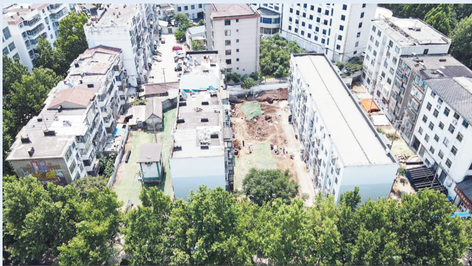
城东街道正在进行老旧小区提升改造。
