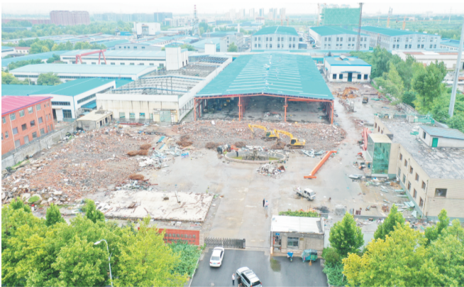
7月23日,一家公司正在进行拆除。
