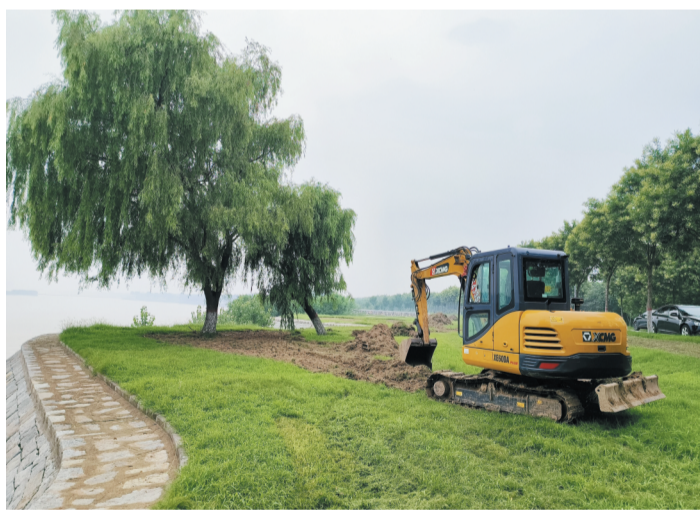
黄河郊野公园小开河段工程正在施工。
