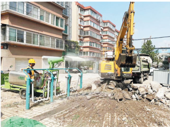
7月27日，西苑小区东区正在进行雨污分流改造。
