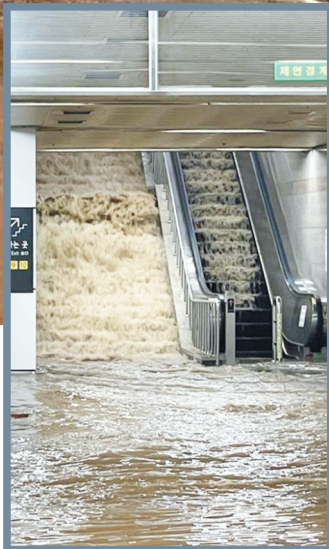
首尔铜雀区地铁7号线梨水站被淹,雨水沿着楼梯翻涌而下。
