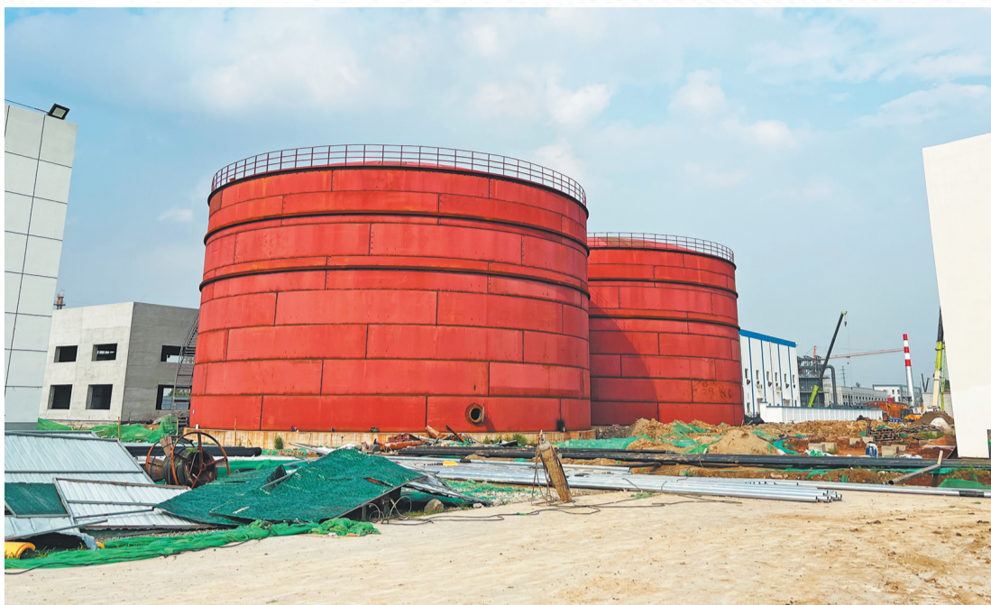
民祥化工科技产业园项目。
