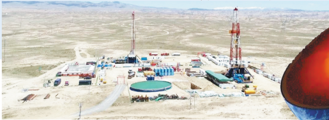
青海共和盆地干热岩压裂与定向钻探现场
