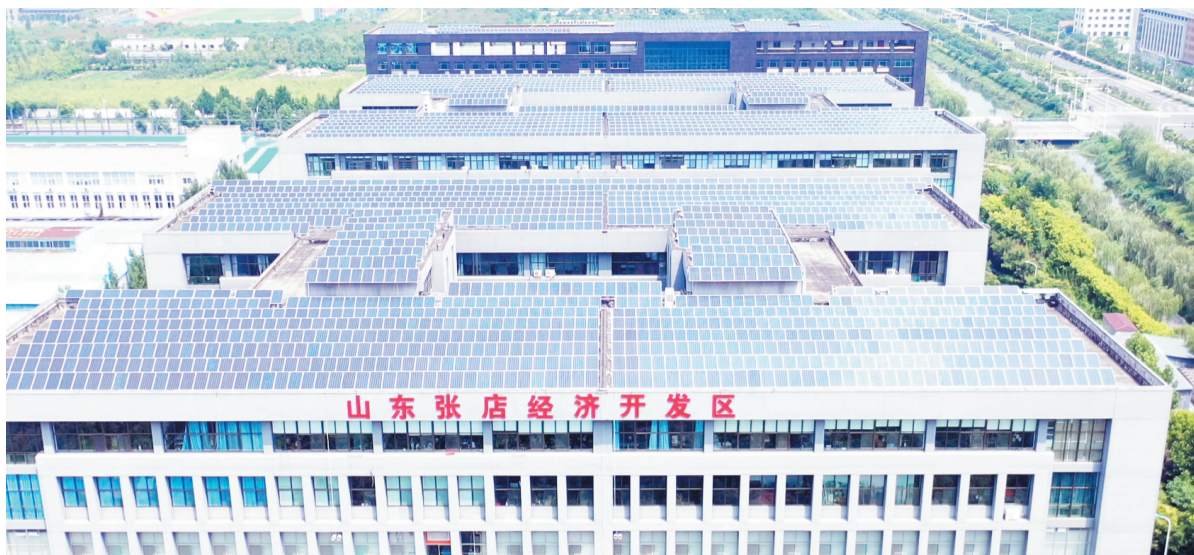
光伏发电应用于办公场所的房顶。
