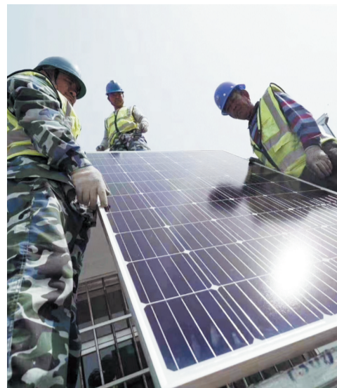
工作人员正在安装光伏设备。
