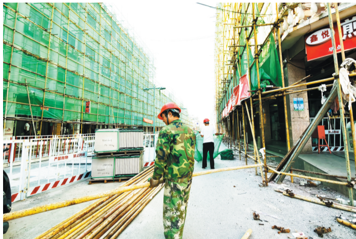
街区改造施工正在进行中。
