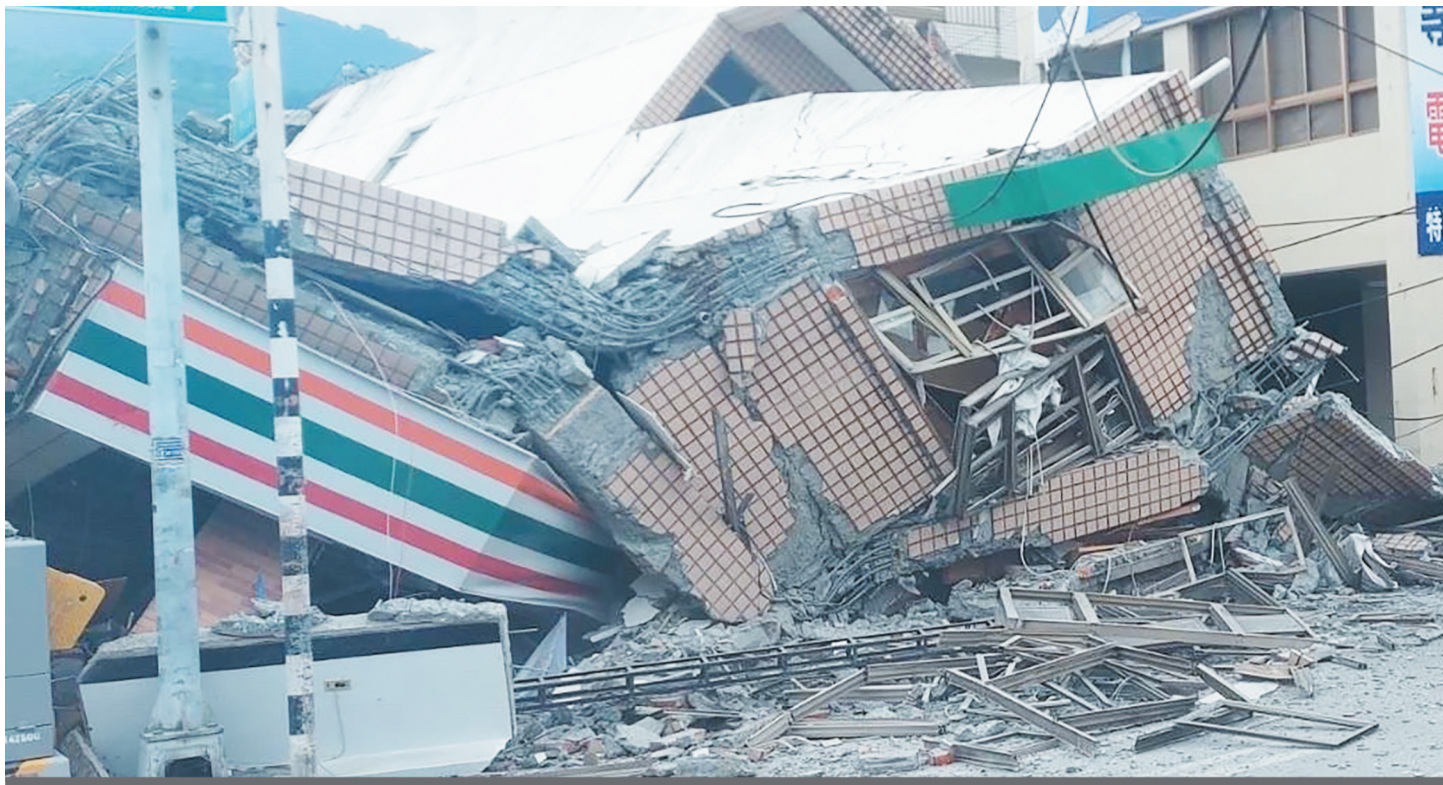
台湾花莲县玉里镇一大楼倒塌。
