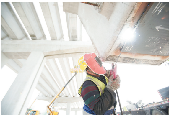
工人正在进行焊接作业。资料照片
