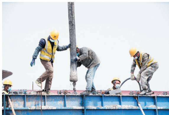
工人正在施工。资料照片
