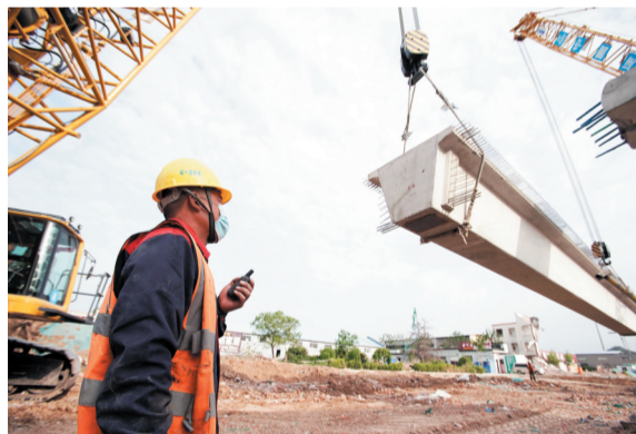
工人正在吊装作业。资料照片
