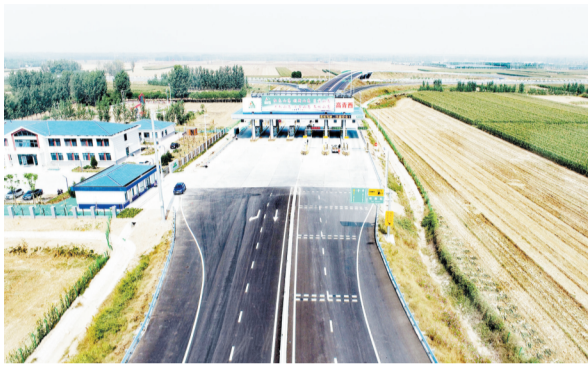
济高高速黑里寨出入口
