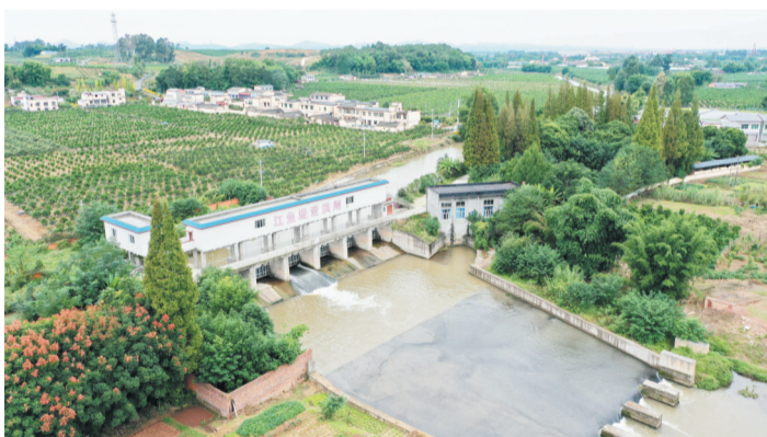
10月6日拍摄的位于四川省眉山市彭山区境内的通济堰灌区江鱼堤泄洪闸(无人机照片)。
