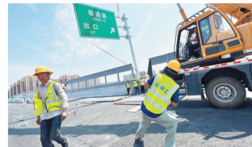
6月21日 淄博快速路原山大道段,交通安全标牌开始安装。
