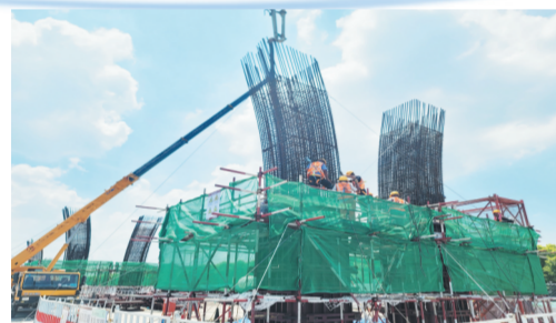
7月19日 全线首根墩柱,在原山大道项目现场开始施工,快速路项目建设全速推进。
