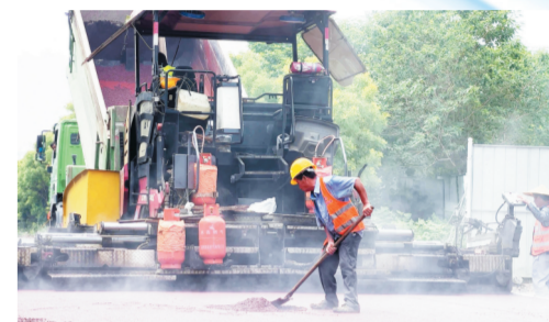
7月6日 淄博快速路原山大道段全速推进,主线桥进入清扫整理阶段,地面正在施工慢行一体系统。
