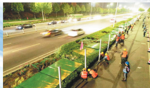
2021年5月12日 淄博市城市快速路网一期工程鲁泰大道项目,开始进行道路封闭,正式进入施工准备阶段。
