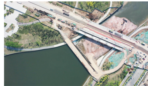
4月20日 淄博快速路原山大道段跨孝妇河新建辅道桥工程首桩开钻,孝妇河桥新添“左膀右臂”。
