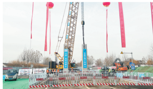
12月8日 全线首根预制装配式墩柱成功吊装。
