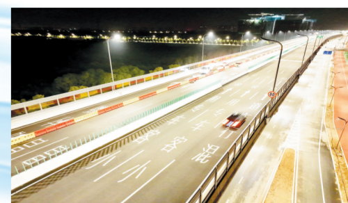
8月1日 原山大道高架桥及地面道路(新村路—麻营立交)、金晶大道高架桥段通车。
