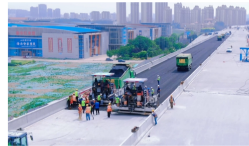
6月12日 淄博快速路昌国路路段桥面沥青首件摊铺顺利完成,桥梁主体工程进入最后一道工序。
