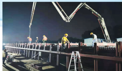
8月4日 全线首片箱梁,在原山大道项目开始施工。自此,快速路项目陆续迈入上部结构施工阶段。
