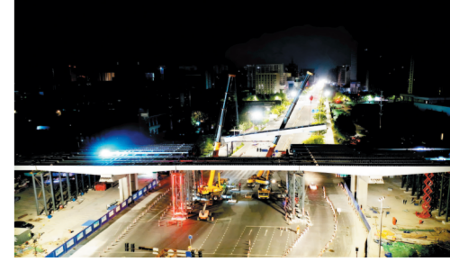
4月26日 鲁泰大道快速路高架桥跨柳泉路口施工。
