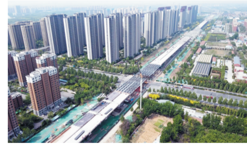
5月9日 淄博快速路鲁泰大道段北京路路口,跨路口吊装顺利完成。
