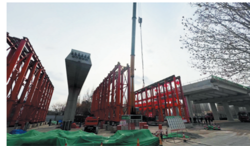
2022年1月5日 淄博快速路鲁泰大道段主线桥首跨钢箱梁成功吊装。
