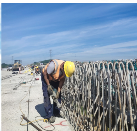
济淄高速施工现场
