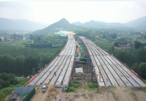
临淄高速施工现场
