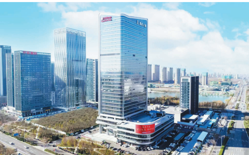
淄博新区商务中心鼎城大厦(国家优质工程)
