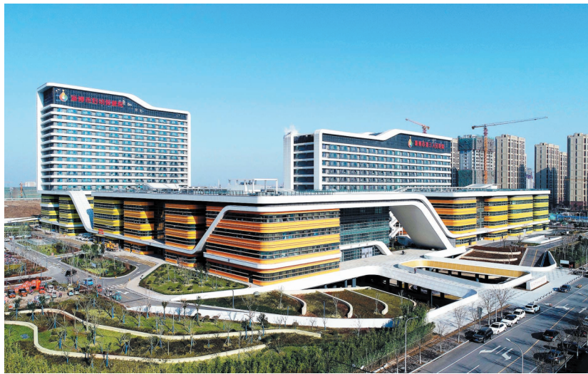
淄博市妇幼保健院新院区工程(国家优质工程)
