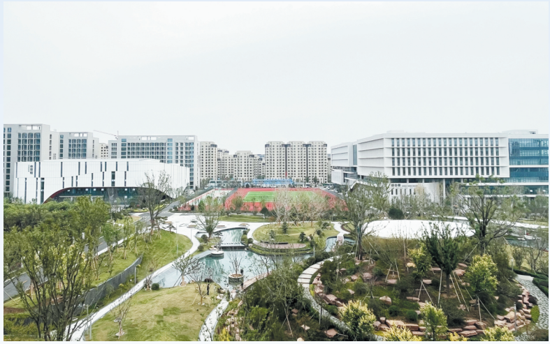
淄博职业教育产教实训基地一期建设项目(钢结构金奖)
