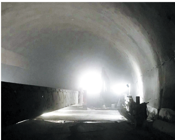
临临高速岳阳山隧道
