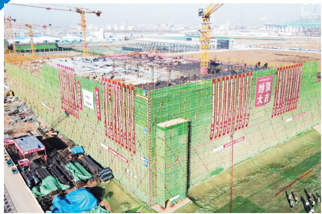
淄博经开区新建产业园区主体建筑提前完成封顶。
