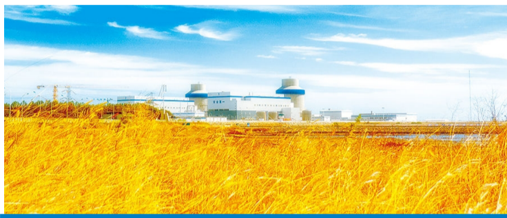
山东海阳核电站外景
