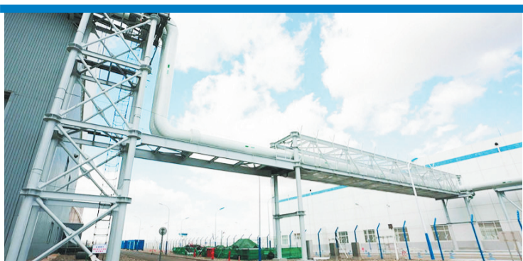
山东海阳核电站“暖核一号”项目输水管道
