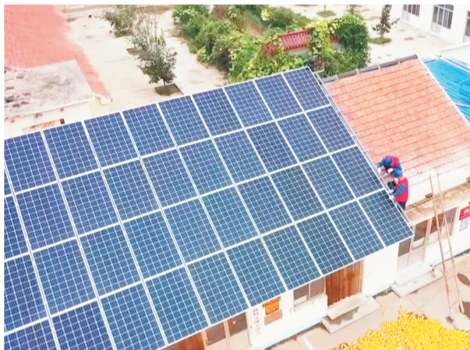
供电公司员工对居民家的光伏设备进行检查。
