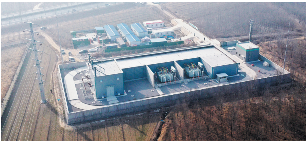
110千伏联伍变电站鸟瞰图
