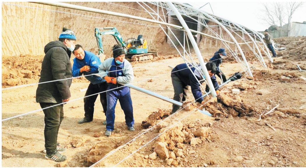
北羊村千亩现代蔬菜产业园施工现场,工人们正紧张地搭建全新的钢架大棚。
