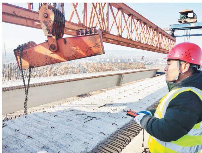
高希峰在架梁施工现场。
