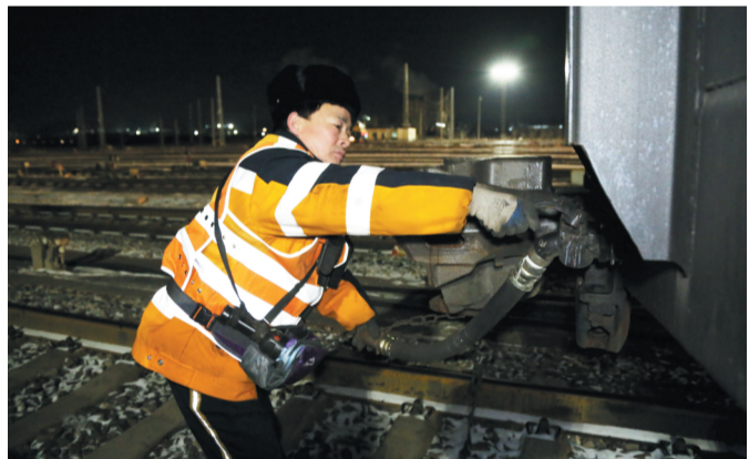
赵启功冒着夜间的严寒,正进行排风作业。
