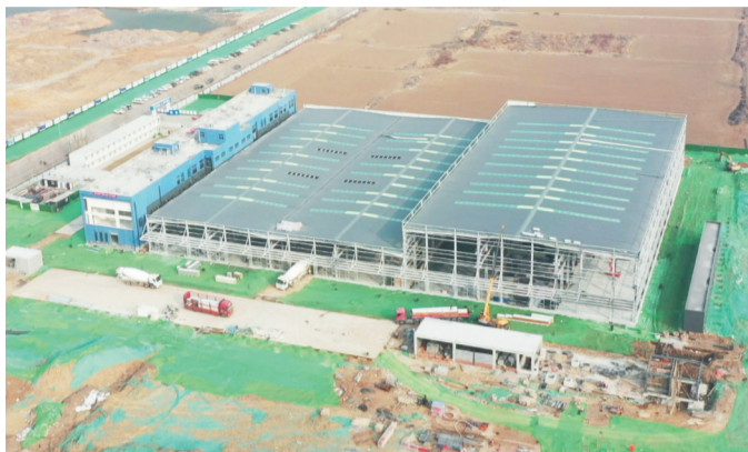
阿特拉斯·科普柯产业园施工正全面有序推进。
