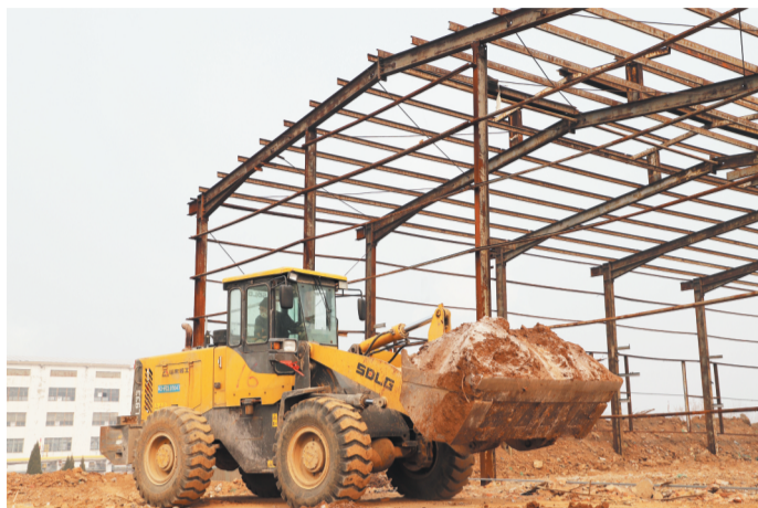
环保型溶剂技术改造项目施工现场
