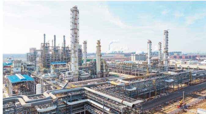
滨华新材料碳三碳四综合利用项目正在快速推进。
