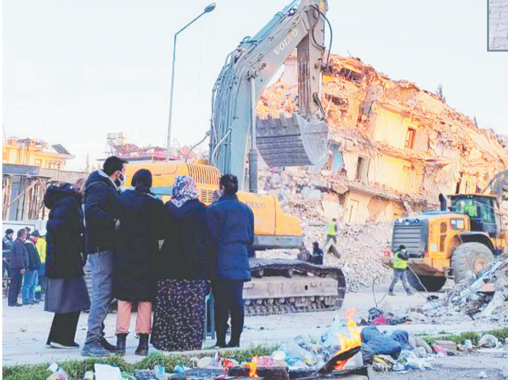
安塔基亚市区，挖掘机正在废墟里翻找，人们在一旁张望。
