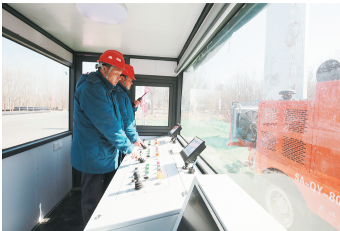
操作人员在控制室内进行智能化放线施工。
