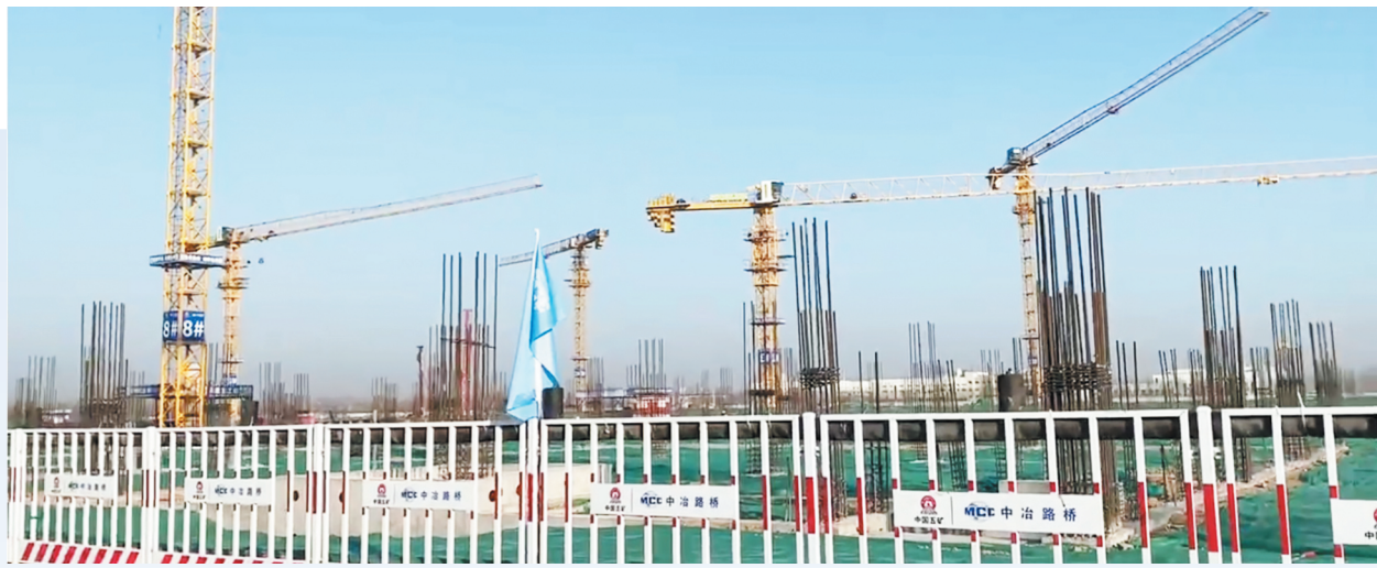
高青经济开发区黄三角药谷产业园项目二期建设现场 视频截图
