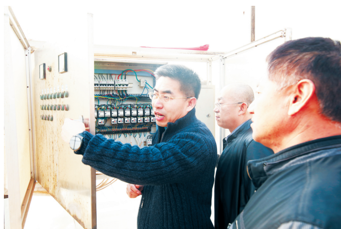
安全专家检查用电设施。
