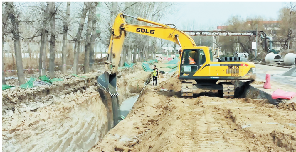
先创区道路施工。
